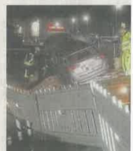
Der silberfarbene Toyota Auris kam erst auf einem Haufen mitten in der Baustelle zum Stehen.
